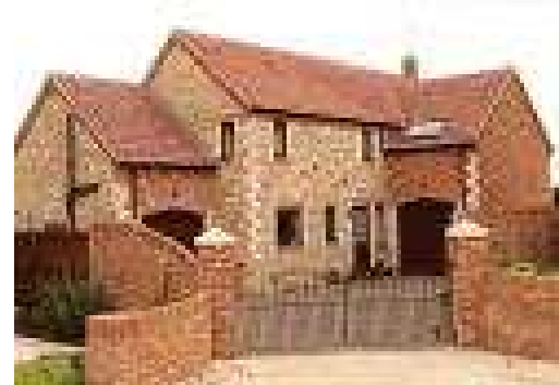
Constructions en hausse, intérêts en baisse
